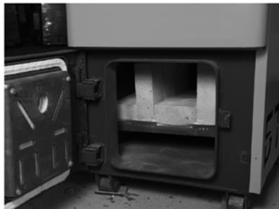
Чищення теплообмінника необхідно поєднувати з чищенням корпуса вентилятора, та каналів подачі повітря.
